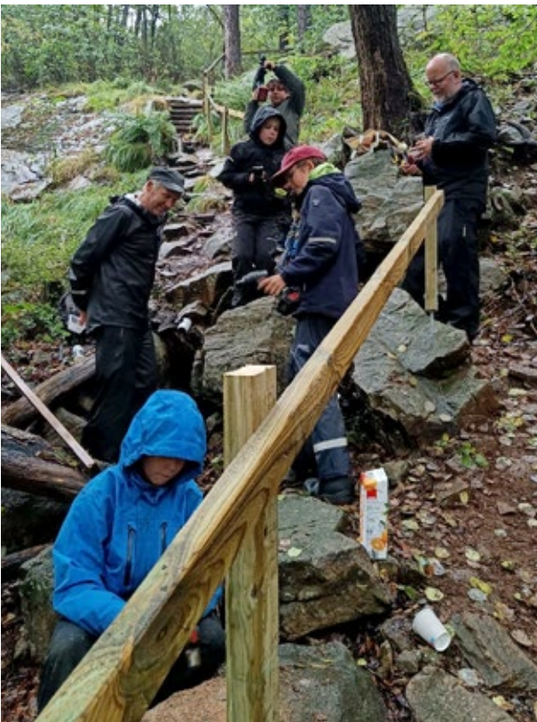
Speidere på Tinnheia lager rekkverk.
