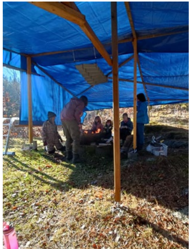
På høsten monterte vi et reisverk ved gapahuken.
